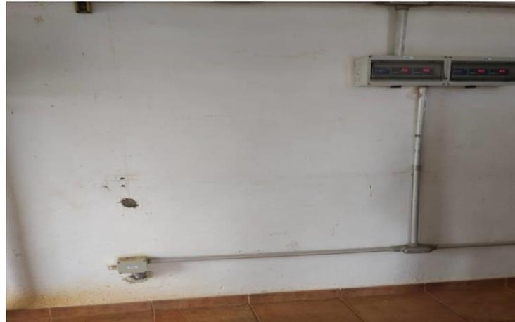
Foto: Sistema de Emergencias para la Detección de Fugas de Cl<sub>2</sub>
