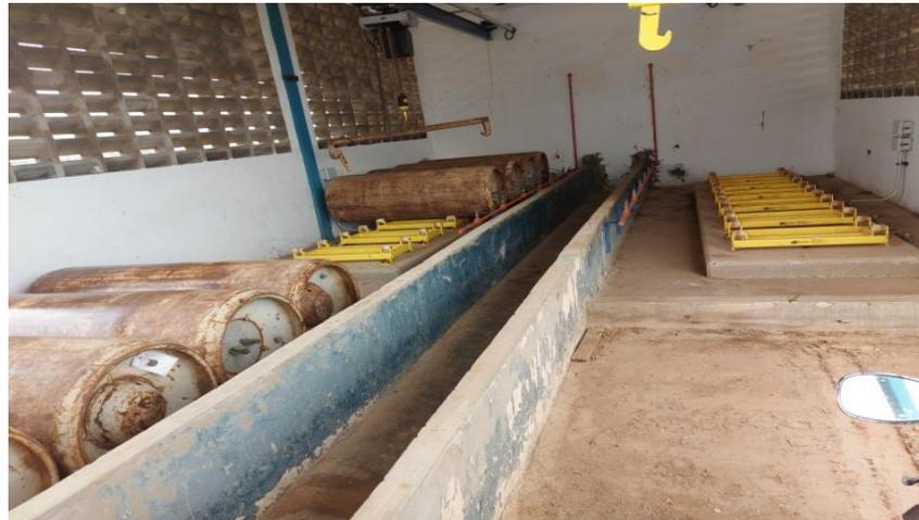
Foto: Base para Evitar que se Rueden los Cilindros de Cl<sub>2</sub>
