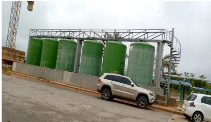
Foto: Tanques de Almacenamiento de Sulfato de Aluminio Liquido
