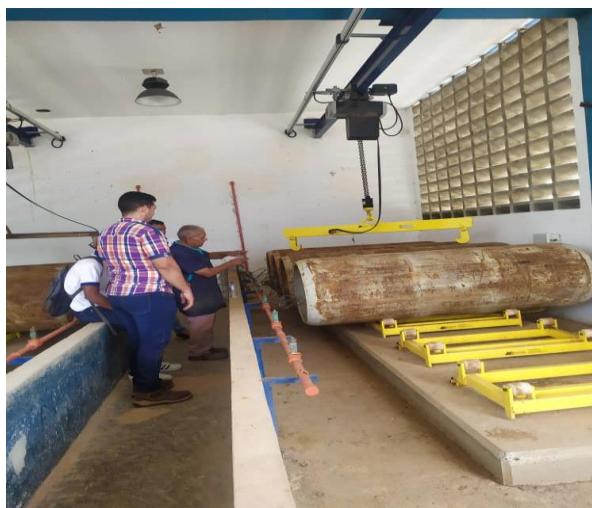
Sala de Baterías
