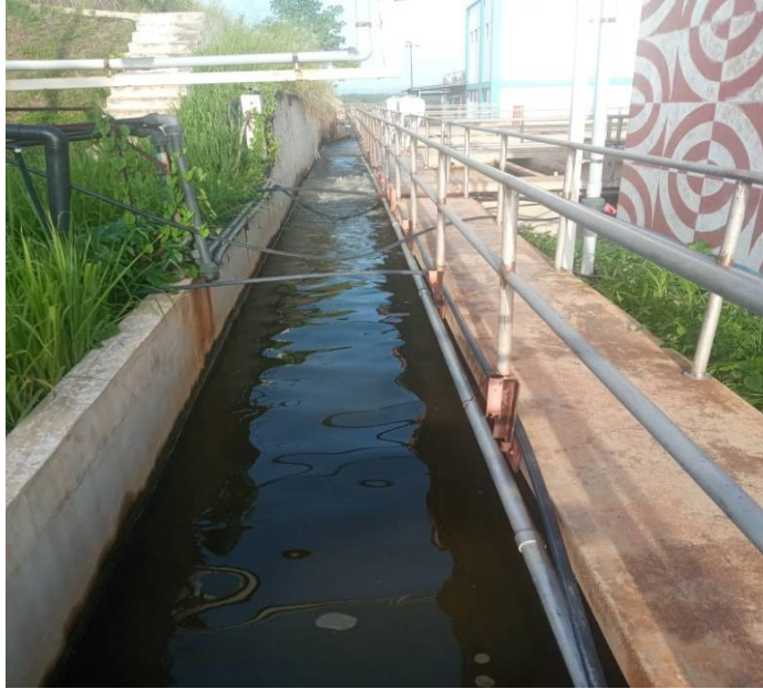
Canal que unen la salida de agua Sedimentada
