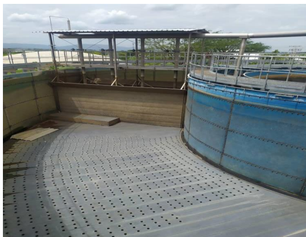
Vista del Módulo # 1 de Flotación en mantenimiento
