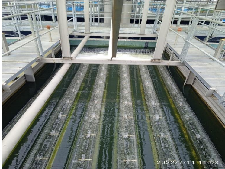
Área de salida de agua clarificada
