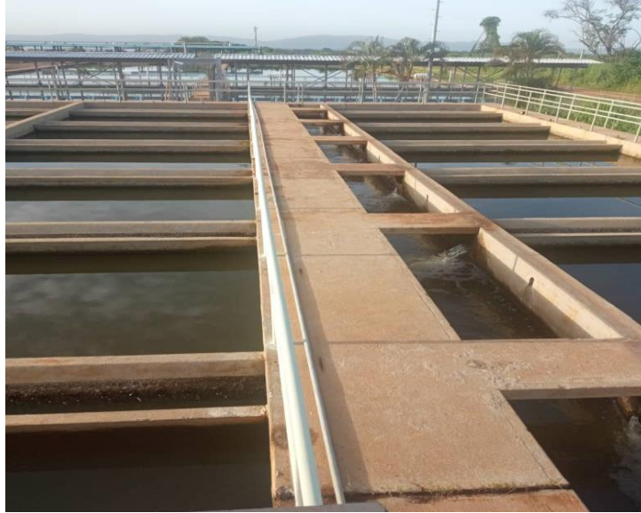
Vista del Sedimentador # 3 Sistema D.
