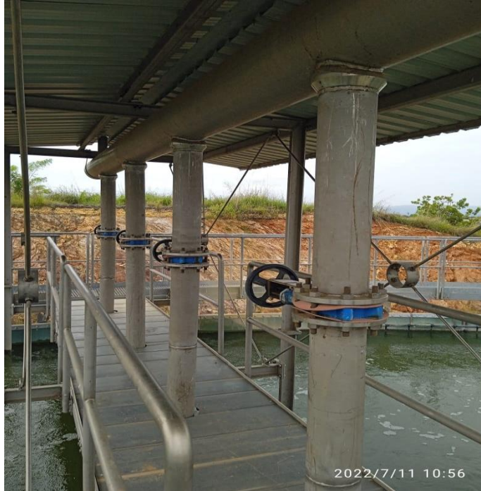
Tuberías de Inyección de agua saturada
