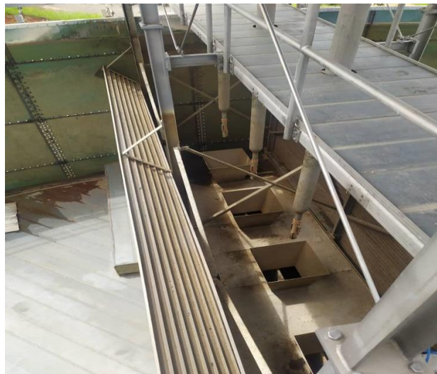
Tuberías de inyección de agua saturada
