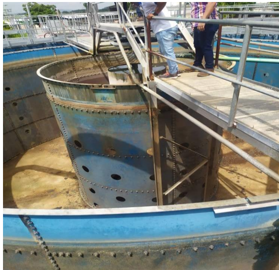
Vista del Módulo # 1 de entrada de agua, que está en mantenimiento
