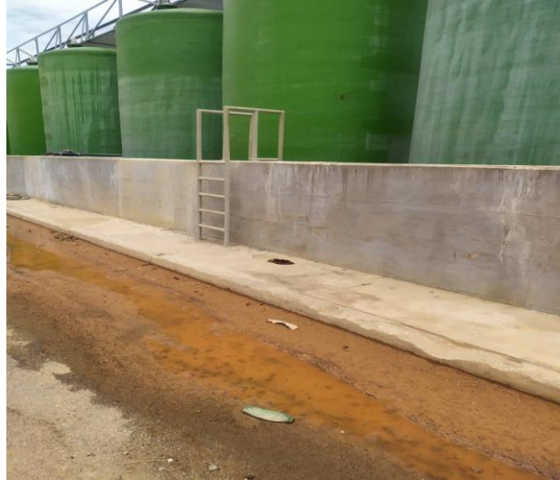
(06) Tanques de almacenamiento de Sulfato líquido
