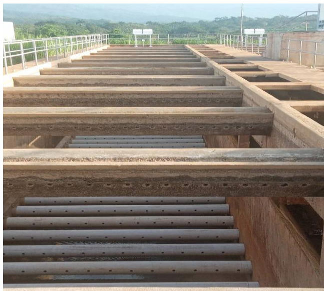
Sedimentador # 1 en rehabilitacion
