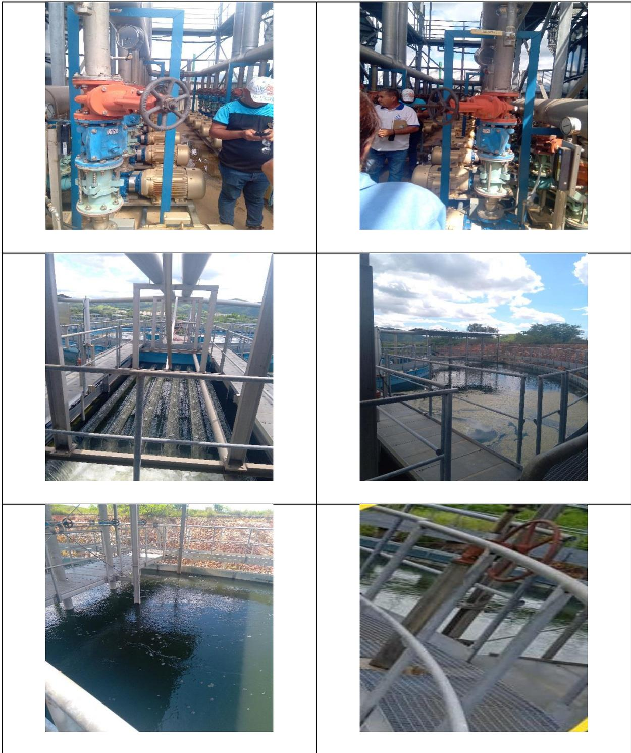
**Tabla de ilustraciones 5.** Módulo #2 de flotación, bombas de saturación, vertedero de drenaje, nata compacta, válvulas de saturación y válvulas telescópicas
