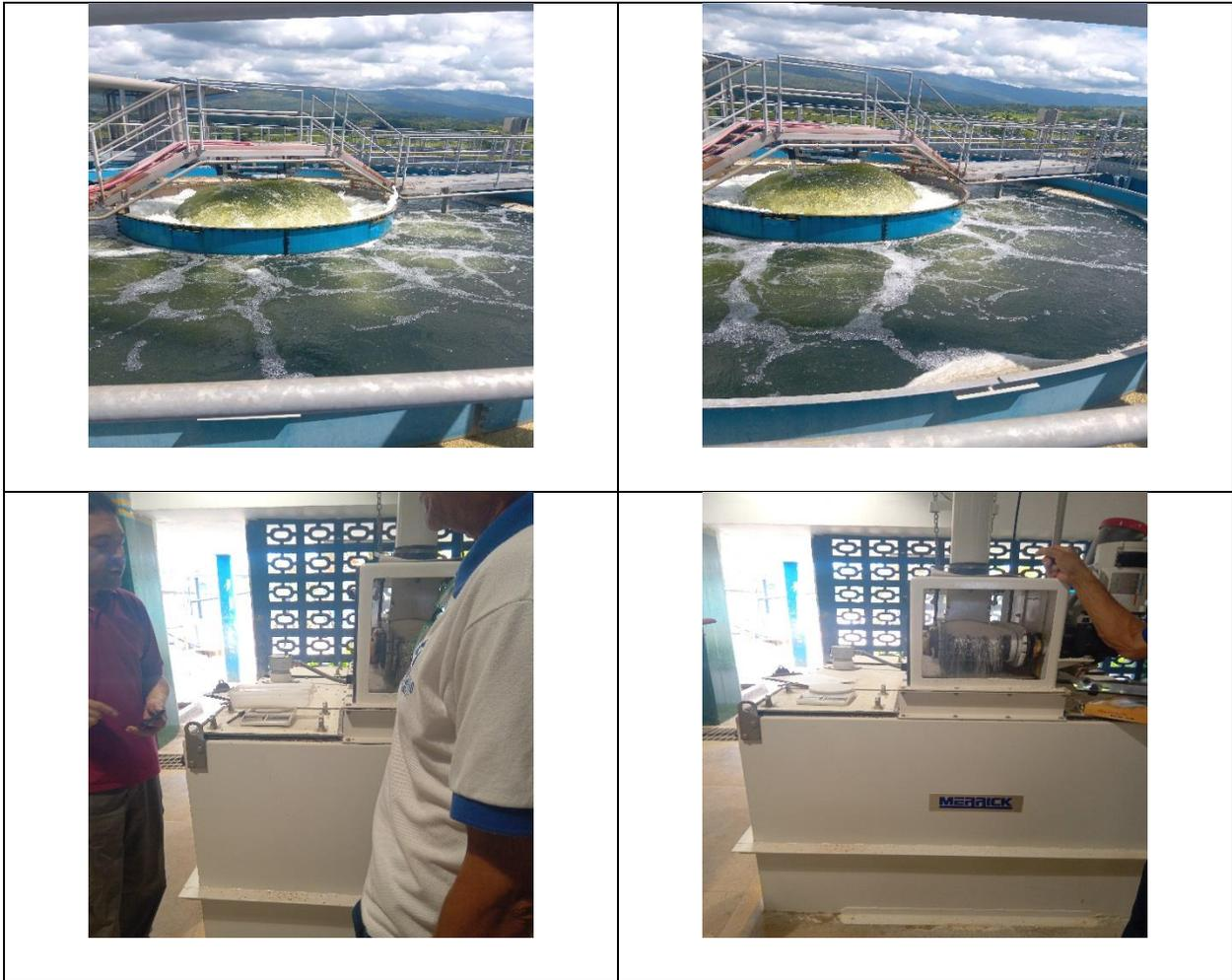
**Tabla de ilustraciones 3.** Mezcla rápida, mezcla lenta, dosificadores de sulfato de aluminio sólido.
