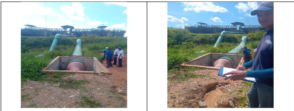
**Tabla de ilustraciones 2.** Entrada de agua cruda a los módulos #1, #2; y tubería de salida que contiene el agua clarificada dirigida al proceso.
