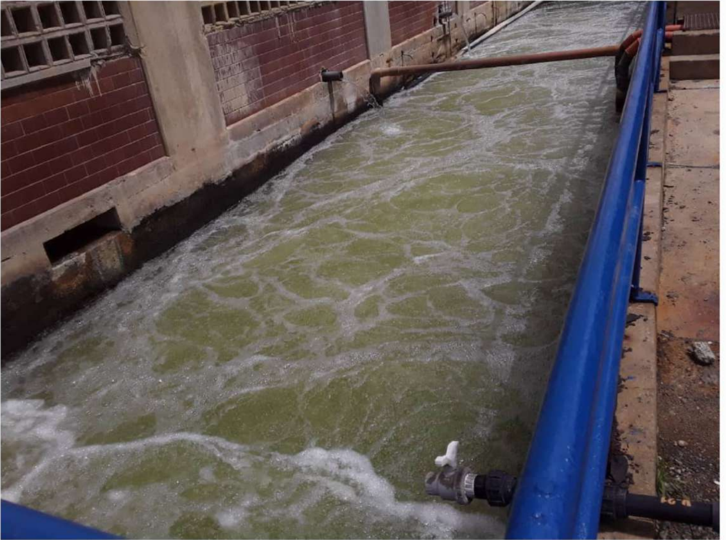
Canal de entrada
