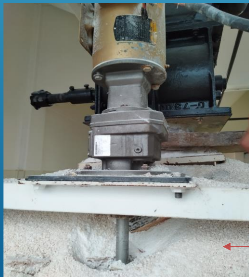
Entrada al tanque de mezclado de sulfato de aluminio sólido, regulado mediante tornillo sin fin horizontal.
