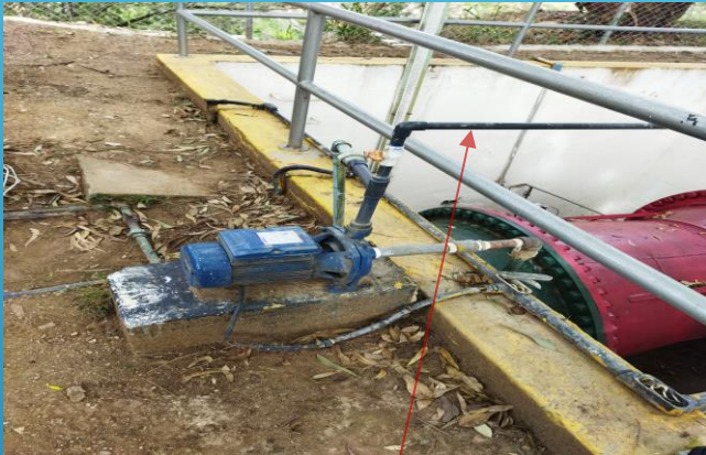
Toma de muestra de agua cruda: color, turbiedad, ph, temperatura.
