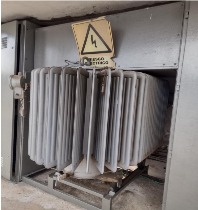
TRASFORMADOR ELECTRICO QUE RECIBE 6600V Y LO TRANSFORMA A 440V
