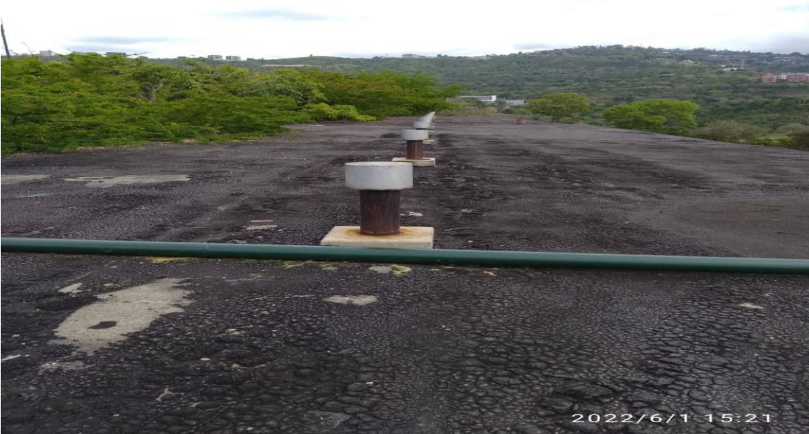
Superficie del tanque de lavado.
