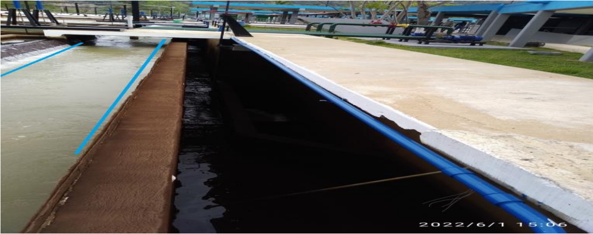
— Canal de entrada y distribución de agua hacia las galerías de los filtros.
