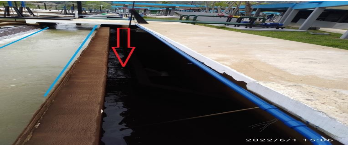
Agua de Lavado de Filtros. (Canal de drenaje/recirculación).
