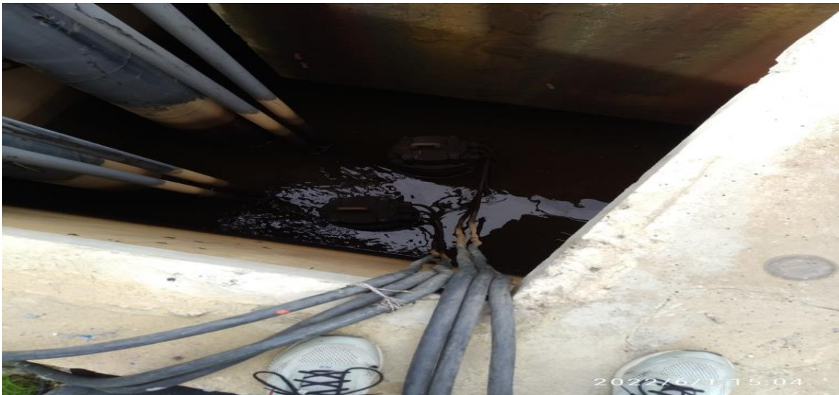
Bombas de Recirculación.
