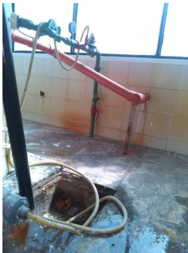
Dosificación de agua y mezcla con sulfato solido
