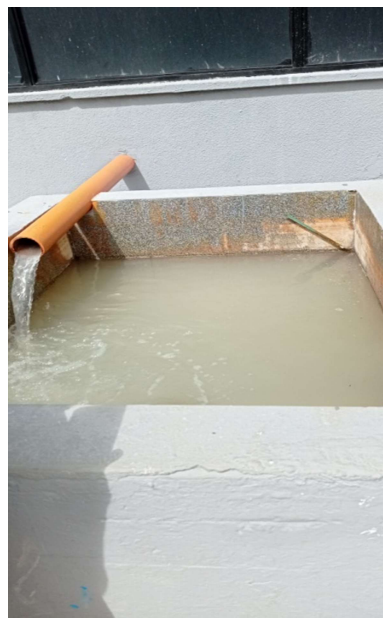
Fig. 10. Tanque donde se contiene el sulfato acuoso
