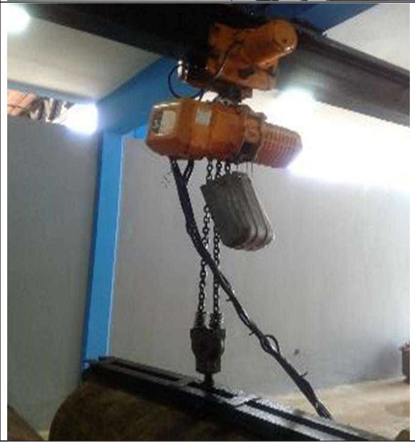
Suministro de cloro a la planta: de dónde lo traen, cómo lo transportan y cada cuánto
