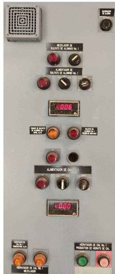
Panel de control del motor que mueve el tornillo sin X
