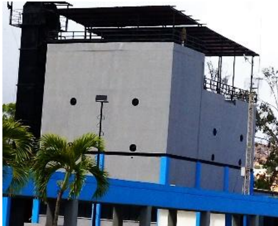
Almacén de sulfato sólido
