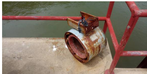
Materiales y equipos en desuso entre B1 y B2
