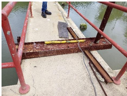
Actuador de la Tanquilla de Sedimentación de Lodos
