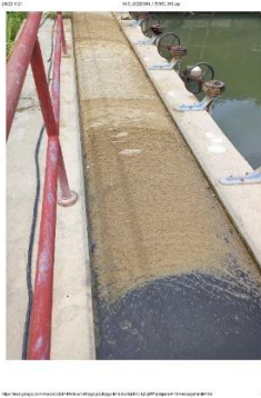
Canal de Entrada Mezcla Lenta
