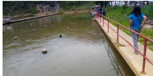
Sedimentador y Floculación B1
