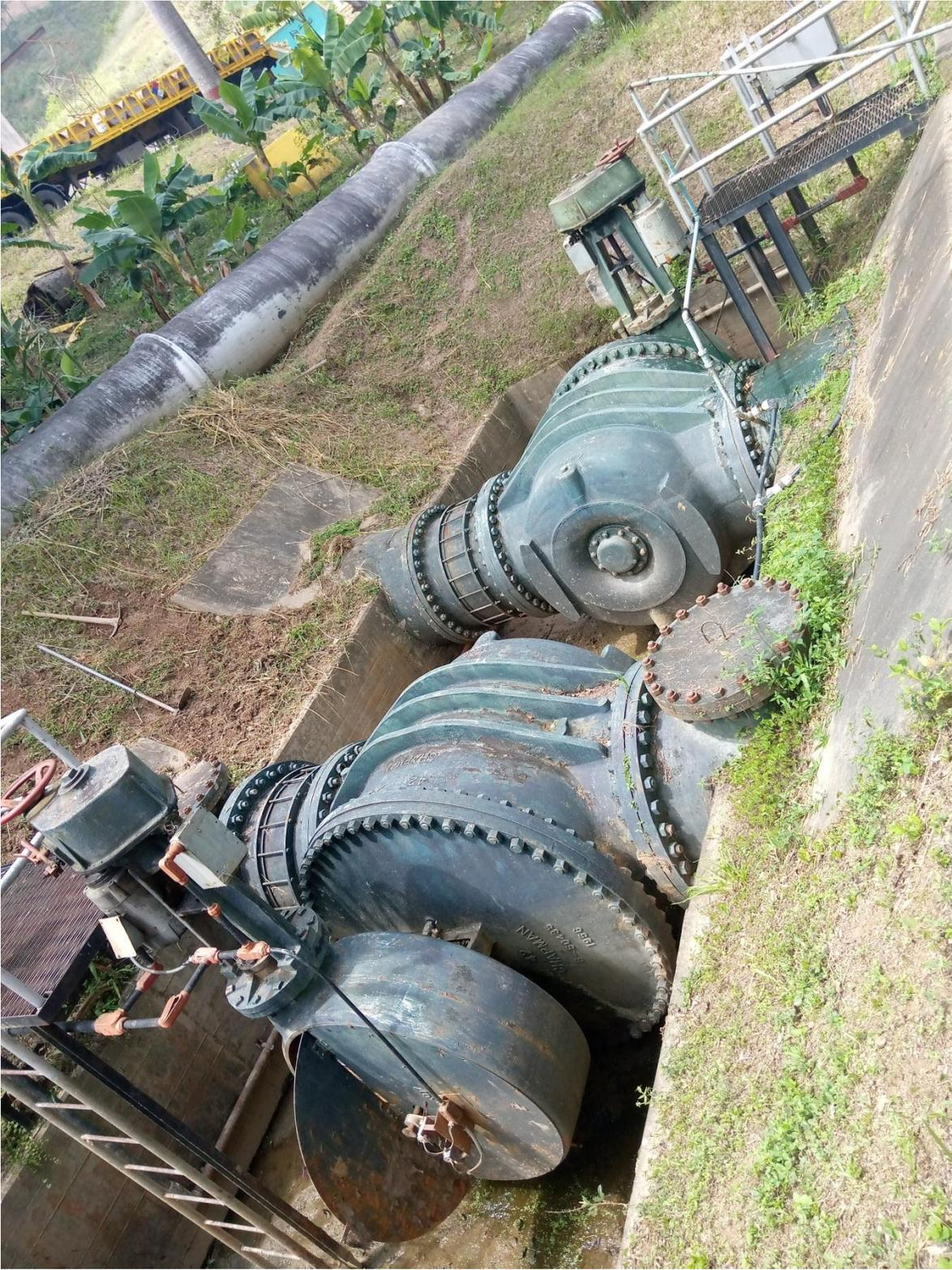
Después de las roto-válvulas el agua llega a la tanquilla principal por medio de una tubería de 72" de diámetro. Donde se procede a inyectarle cloro para su desinfección por medio de una tubería de 6" de diámetro.
