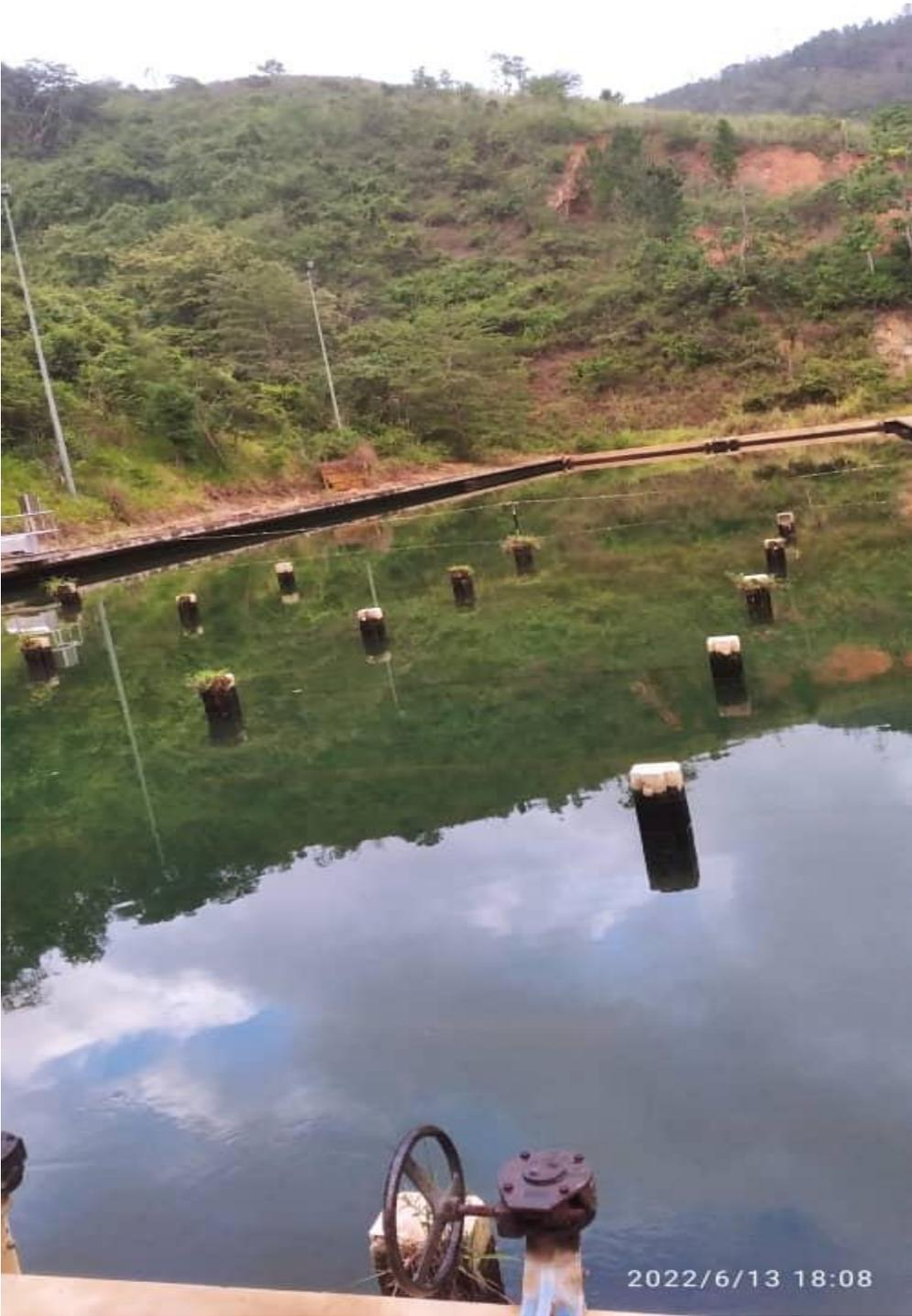
También cuenta con una sub-estación para el drenaje de los mismos, consta de 3 actuadores que se operan de manera manual o automática. 1 para cada sedimentador, y un tablero eléctrico para su operación automática, cada dren cuenta con una válvula del tipo mariposa.
